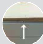
La fixation du profilé de sous-face par pointe, clip ou vis doit être assurée côté languette.
