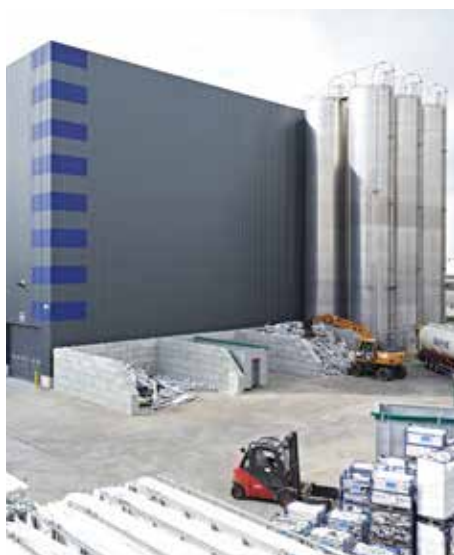
Usine de recyclage à Diksmuide, Belgique
